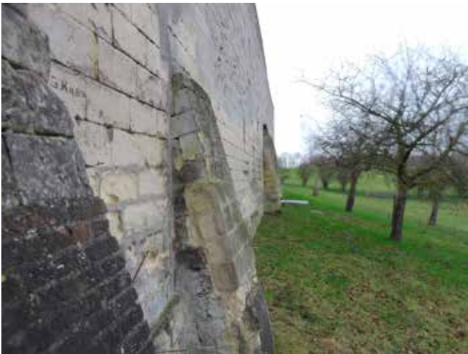
13. Vanwege de ligging in de helling is de muur voorzien van steunberen
