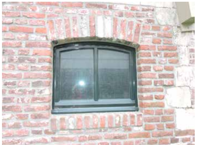
21. De ramen in het vernieuwde metselwerk zijn aan de courzijde te dateren rond 1960, aan de veldzijde zijn ze recent en voorzien van dubbel glas
