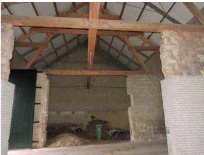
28. Blick naar de entreezijde van het complex. De spanten en muren van de schuur zijn gestabiliseerd met parallel aan de nok aangebrachte balken in larix. Ook de open verbindingen in de muren van de compartimenten links en rechts zijn daarmee afgedekt. Aan de verkleuring van de mergel is te zien dat er ooit brand heeft gewoed in de schuur, wat mede een reden geweest zal zijn voor het opdikken van de muren met baksteen
