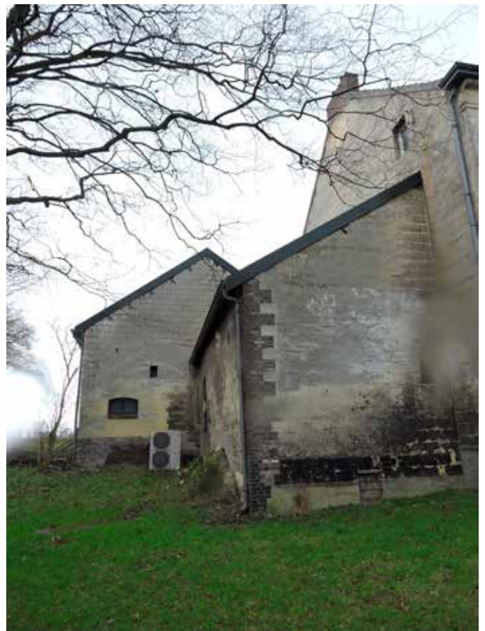
5. Dit bouwdeel sluit aan op de grote stalvleugel rechts van de poort naar de binnenplaats
