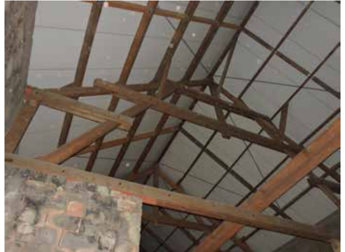
27. Ook hier zijn de spanten uit de bouwtijd maar is het dakvlak vernieuwd
