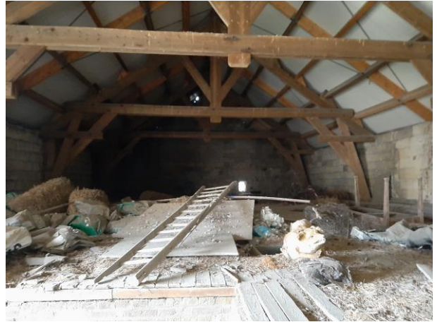
Foto 8. Verdieping boven voormalige stallen zuidvleugel
