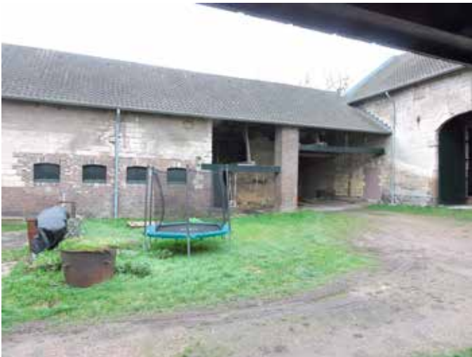
18. De poortdoorgang naast de schuur met daarnaast een open gedeelte voor de stallen en de stalvleugel zelf
