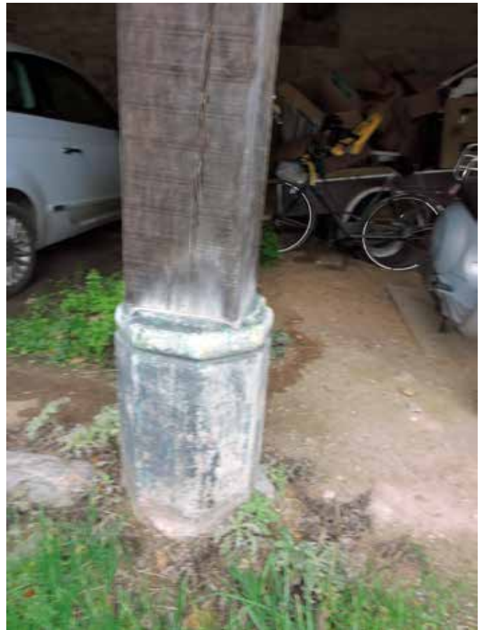
31. De stijen van de stalling staan op geprofileerde stukken Naamse steen
