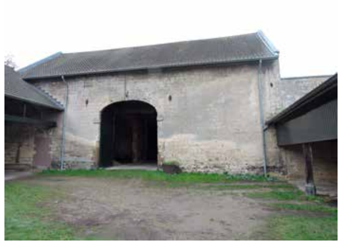
17. De courzijde van de schuur. De asymmetrische plaatsing van de poort wordt hier verklaard: de aanhechting op de poortdoorgang en in het verlengde daarvan de stalvleugel
