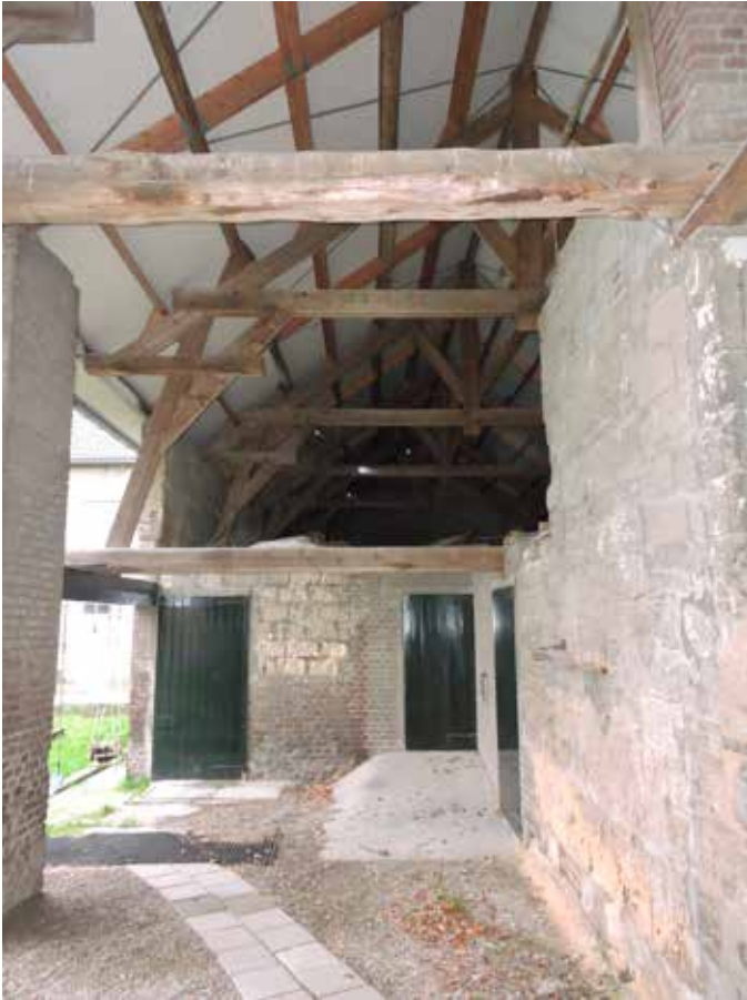
22. Doorkijk door het open stuk aan de rechterzijde van de stalvleugel naar de kap van de eigenlijke stallen, die rechts achter de uitbouw naar de buitenkant verder doorloopt. De spanten dateren uit de bouwtijd, het dak is vrij recent geheel vernieuwd
