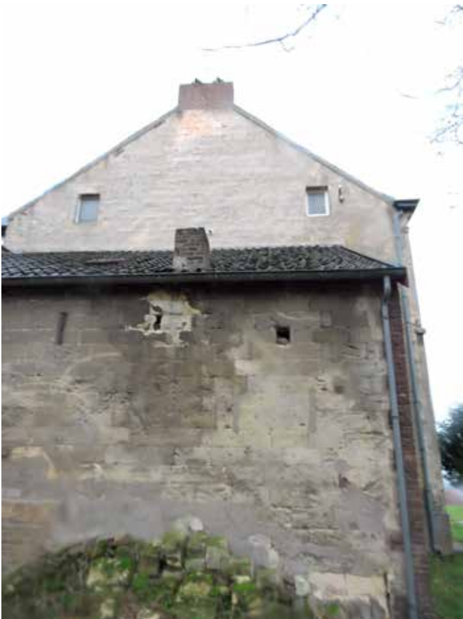
4. Het rommelige oppervlak van de muur is naar alle waarschijnlijkheid het gevolg van door de wind schurende beplanting
