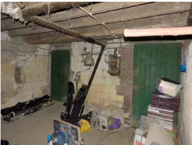
36. De rechter deur voert naar de open ruimte onder het dak van de stalvleugel. De deur links gaat naar de stallen aan de veldzijde, tot bij de poort
