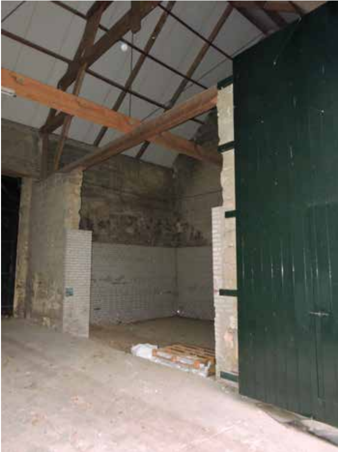
26. De ruimte in de schuur rechts van de poort. Ter stabilisering van de mergel muren is tot verdiepingshoogte een blad opgetrokken in kalkzandsteen op baksteenformaat
