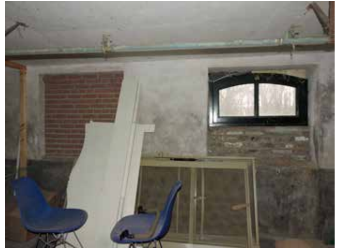
39. Een van de vernieuwde ramen en een dichtgezette deur naar de buitenzijde
