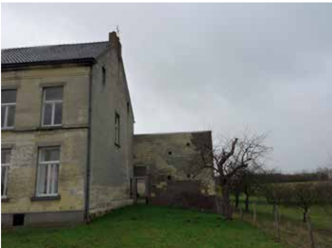
14. De aanhechting van de stalling op het woonhuis, met een deur naar de binnenplaats
