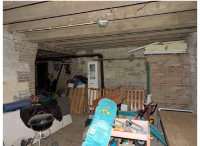
35. Doorkijk naar de rest van de stallen. Rechts staat de wc
