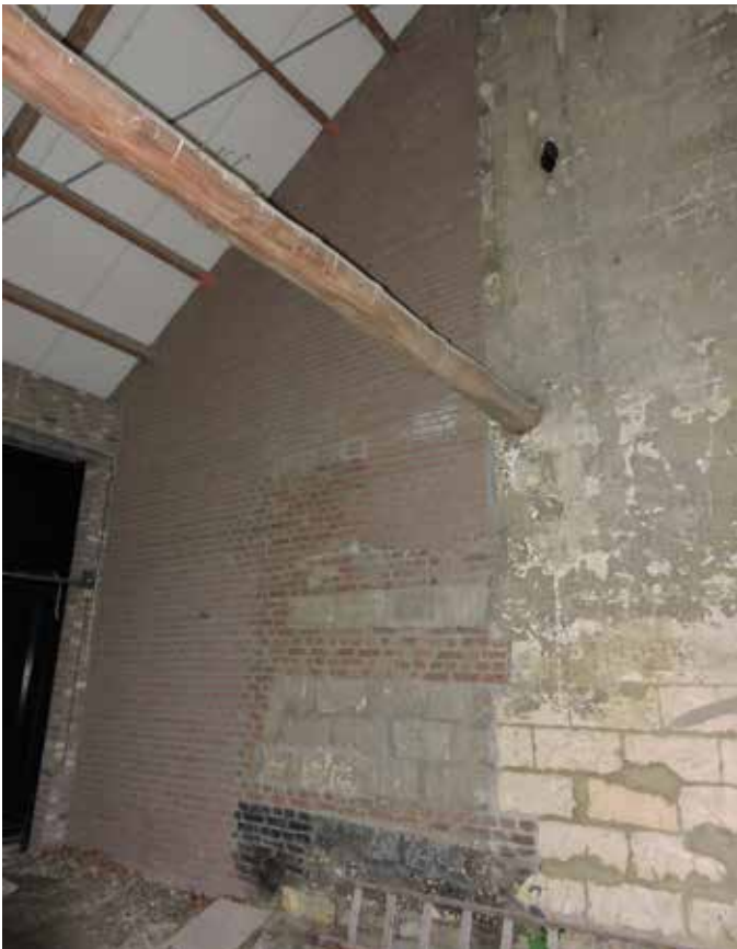
24. De zijmuur van de poortvleugel heeft aan de binnenzijde een nieuw blad van baksteen
