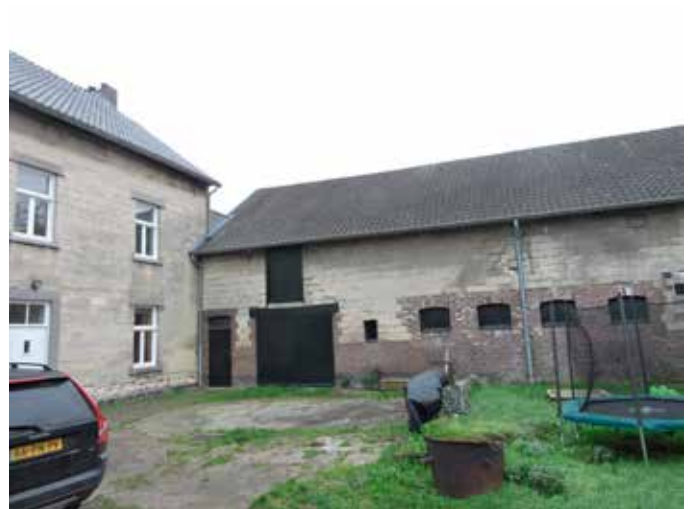
19. Die loopt door tot tegen het huis. Aan de afzoming van de openingen op de begane grond is te zien dat die allemaal vernieuwd zijn. de kleine poort is weer een nog jongere ingreep
